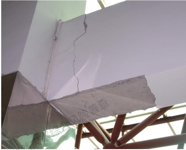
混凝土结构构件裂缝
