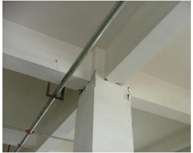
混凝土结构构件裂缝
