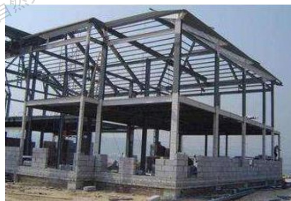
钢和混凝土混杂结构
