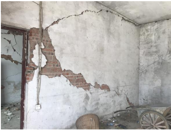
砌体结构构件裂缝
