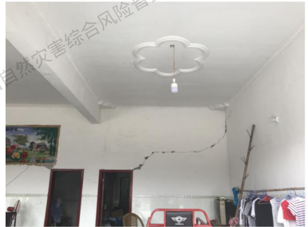
砌体结构构件裂缝
