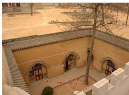
图 C-53~图 C-54 下沉式窑洞（俗称地坑窑）
