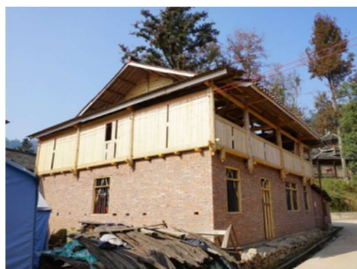
图 C-40 下砖上木围护墙房屋
