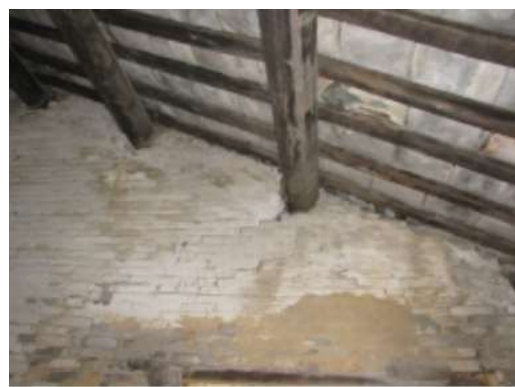
图 D-1、图 D-2 檩条下局部受压裂缝
