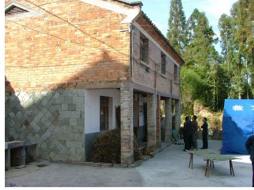
图 C-46 石柱、砖墙混杂的房屋
