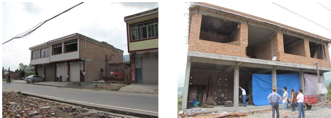
图 C-23~图 C-24 底部大开间的底框房屋
