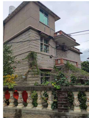
图 C-21~图 C-22 石墙承重，现浇混凝土板房屋
