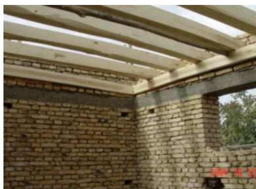
图 C-11~图 C-12 新建砖木房屋，左为平屋盖，右为硬山搁檩坡屋盖
