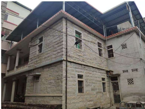
图 C-23~图 C-24 石墙承重、石板楼盖房屋
