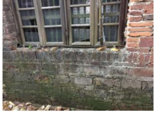
图 D-12 砖墙碱蚀
