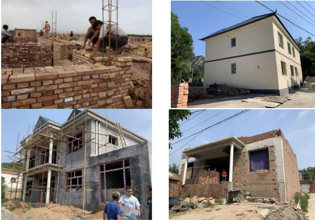
图 C-2~图 C-5 典型砖混结构房屋
