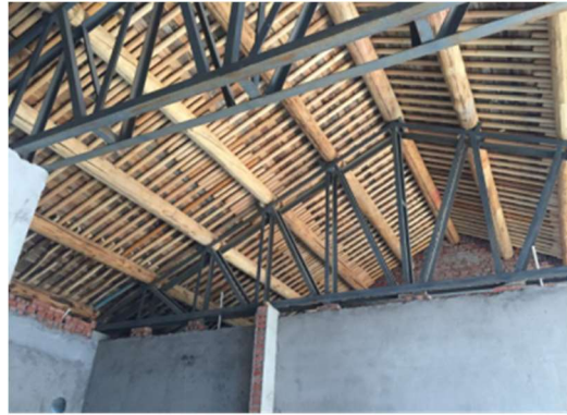
图 C-15~图 C-16 采用轻钢屋架、木檩条的砌体结构房屋
