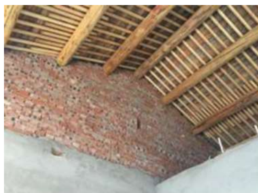
图 C-11~图 C-12 新建砖木房屋，左为平屋盖，右为硬山搁檩坡屋盖
