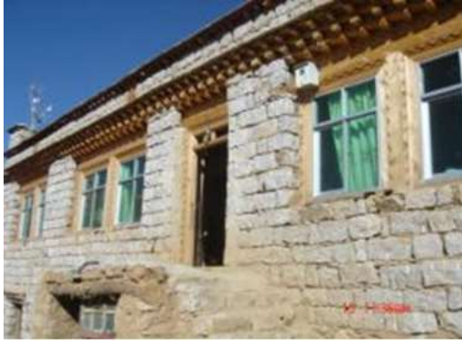
图 C-17~图 C-20 石墙或石柱承重、木（楼）屋盖结构房屋
