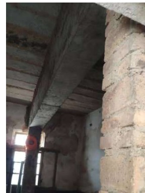
图 C-23~图 C-24 石墙承重、石板楼盖房屋
