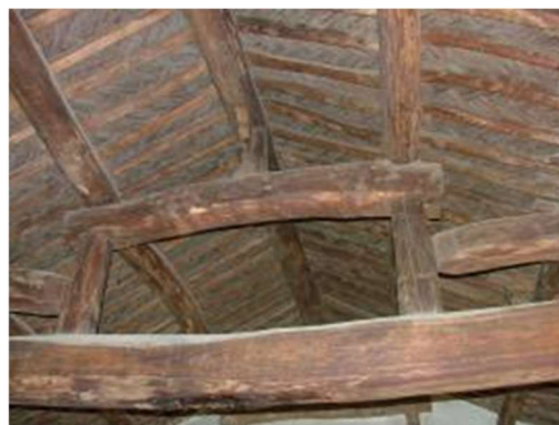
图 C-36 抬梁式木构架
