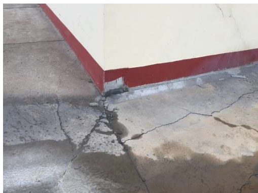
图 D-7、图 D-8 地基基础不均匀沉降引起的散水开裂、墙体裂缝
