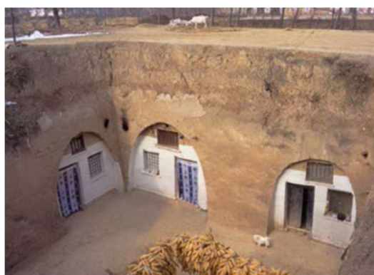
图 C-53~图 C-54 下沉式窑洞（俗称地坑窑）
