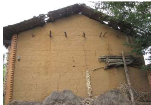
图 C-43~图 C-44 前纵墙为砖墙，其余三面为生土墙的混杂结构房屋
