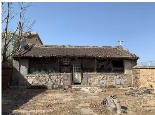
图 D-5、图 D-6 肉眼可见的屋面塌陷变形
