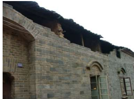
图 C-47~图 C-48 砖土混砌墙体房屋的震害
