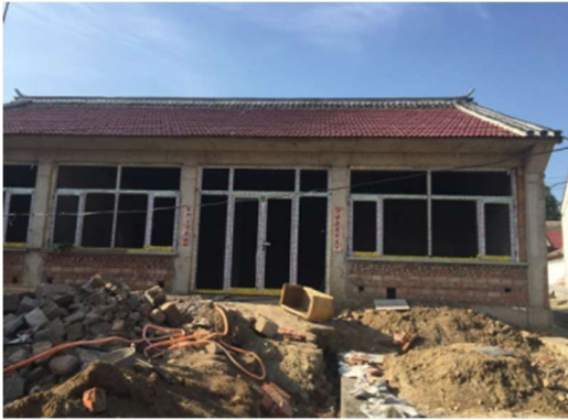
图 C-15~图 C-16 采用轻钢屋架、木檩条的砌体结构房屋
