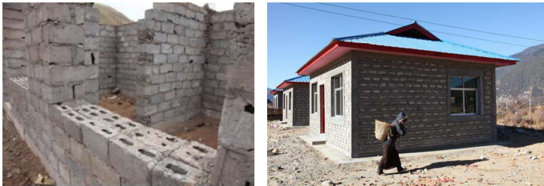
图 C-6~图 C-7 典型砌块砌体结构房屋
