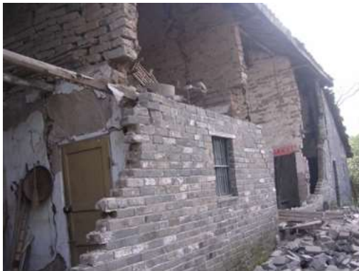
图 C-47~图 C-48 砖土混砌墙体房屋的震害
