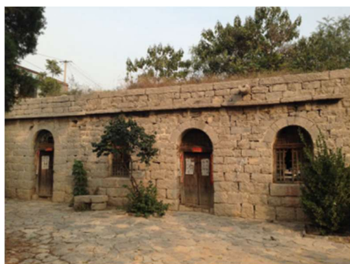
图 C-55~图 C-56 独立式窑洞
