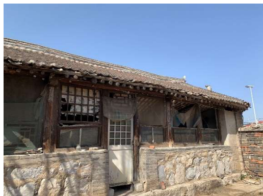
图 D-5、图 D-6 肉眼可见的屋面塌陷变形
