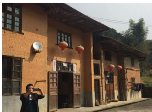
图 C-39 夯土围护墙房屋
