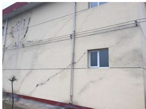
图 D-7、图 D-8 地基基础不均匀沉降引起的散水开裂、墙体裂缝
