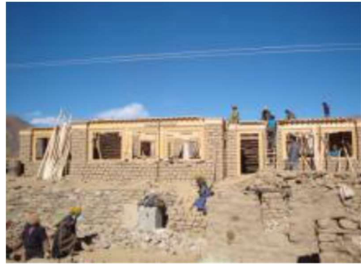
C-30 西藏自治区土坯房屋
