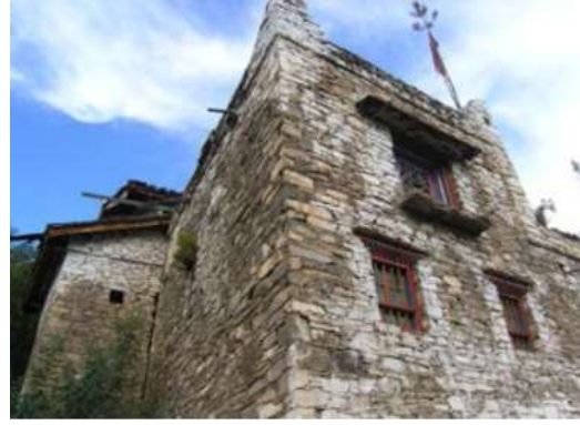
图 C-17~图 C-20 石墙或石柱承重、木（楼）屋盖结构房屋
