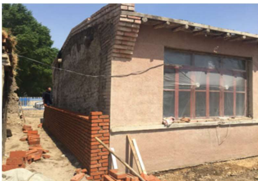
图 C-43~图 C-44 前纵墙为砖墙，其余三面为生土墙的混杂结构房屋
