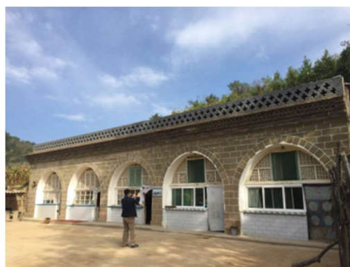
图 C-55~图 C-56 独立式窑洞
