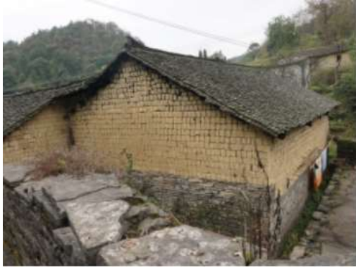
图 C-45 下石墙上土坯墙的房屋
