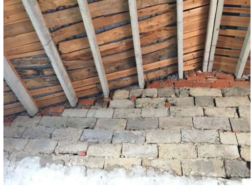
图 C-13~图 C-14 砖或砌块墙承重，预制混凝土檩条、坡屋盖木屋面房屋
