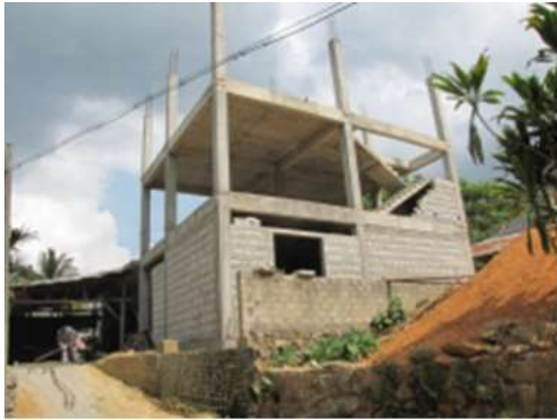
图 C-59 在建的低层框架结构房屋
