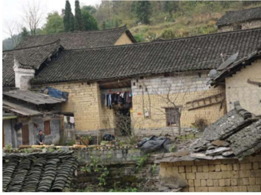
图 C-41 土坯围护墙房屋
