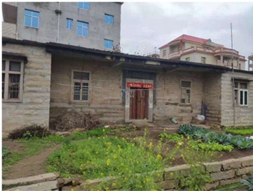
图 C-21~图 C-22 石墙承重，现浇混凝土板房屋
