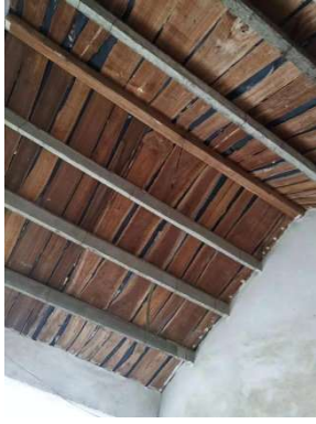
图 C-13~图 C-14 砖或砌块墙承重，预制混凝土檩条、坡屋盖木屋面房屋
