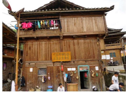
图 C-42 木围护墙房屋
