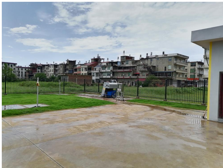
梓埠镇污水处理站
